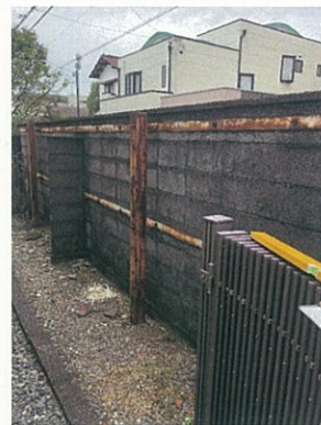
鉄骨造控柱の設置
